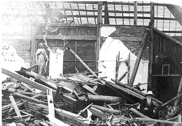
Bão sập nhà thờ Gò Thị 1933
